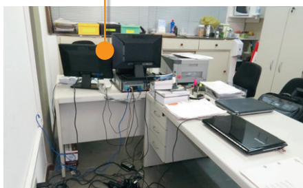
Em Lauro de Freitas, pontos de internet são insuficientes. Computador que poderia melhorar o trabalho ainda está na caixa pela falta de pontos.
