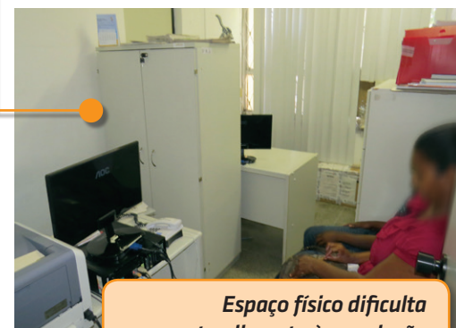
Salas com mofo e umidade fazem parte do cenário
